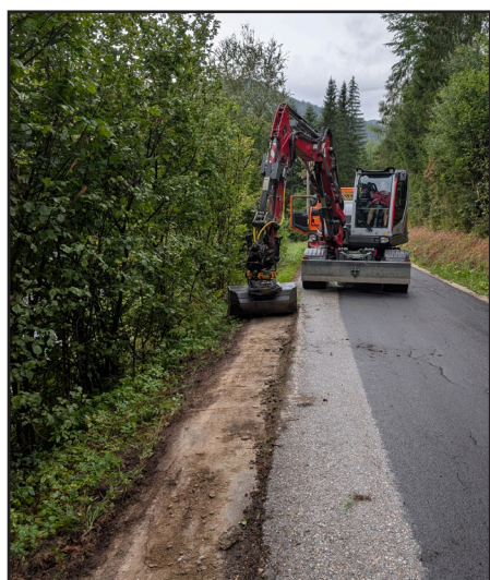
Vorbereitung mittels Radbagger für den Bankettfertiger
