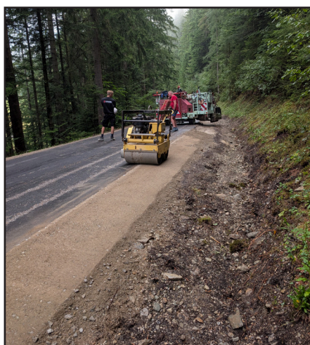
Mit dem Bankettfertiger wurden über 500 t Bankettmaterial eingebaut
